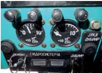
Рис. 2. Лицевая сторона приборной панели гидросистемы в кабине экипажа вертолета Ми-8АМТ (указатель давления основной гидросистемы показывает наличие давления, создаваемого ГУ-9977–00)
