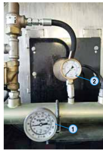
Рис. 7 Термометр и манометр дейсера: 1 – внутренняя шкала температуры с диапазоном от -10^{\circ}\text{C} до +110^{\circ}\text{C} (наружная от 20^{\circ}\text{F} до +240^{\circ}\text{F} ); 2 – внутренняя шкала давления от 0 до 600 кПа (наружная от 0 до 100 psi)
